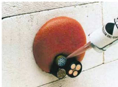
Brtvljenje i provođenje električne instalacije kroz granice požarnih zona
