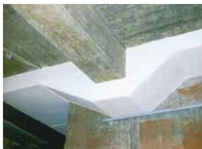
Primjer zaštite od požara električnih instalacija koje za požara moraju funkcionirati
